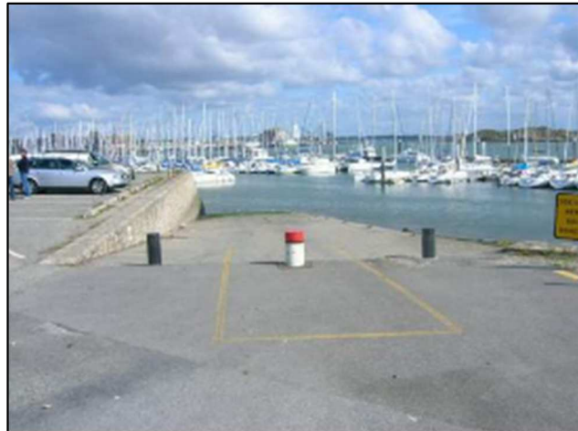
FIGURE 241 - CALE DE MISE A L'EAU DU PORT DE KERNEVEL (SOURCE : WWW.PNEUBOAT.COM)
