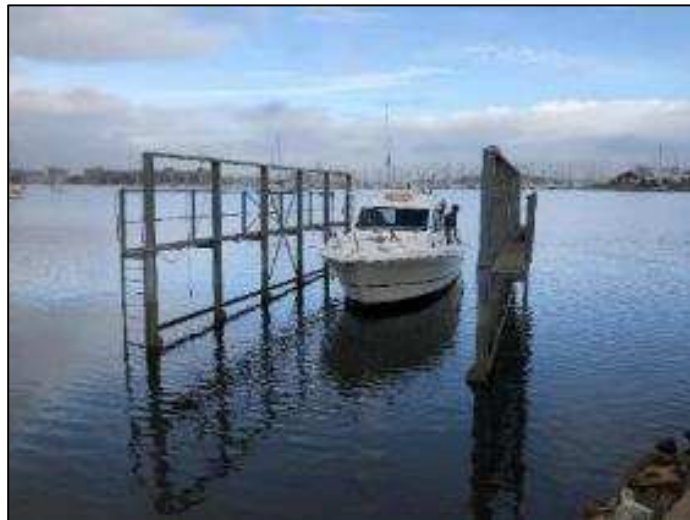
FIGURE 242 - SLIPWAY DU CHANTIER KERNEVEL NAUTIC (PORT DE KERNEVEL A L'ARRIERE-PLAN) - SOURCE : KERNEVEL NAUTIC
